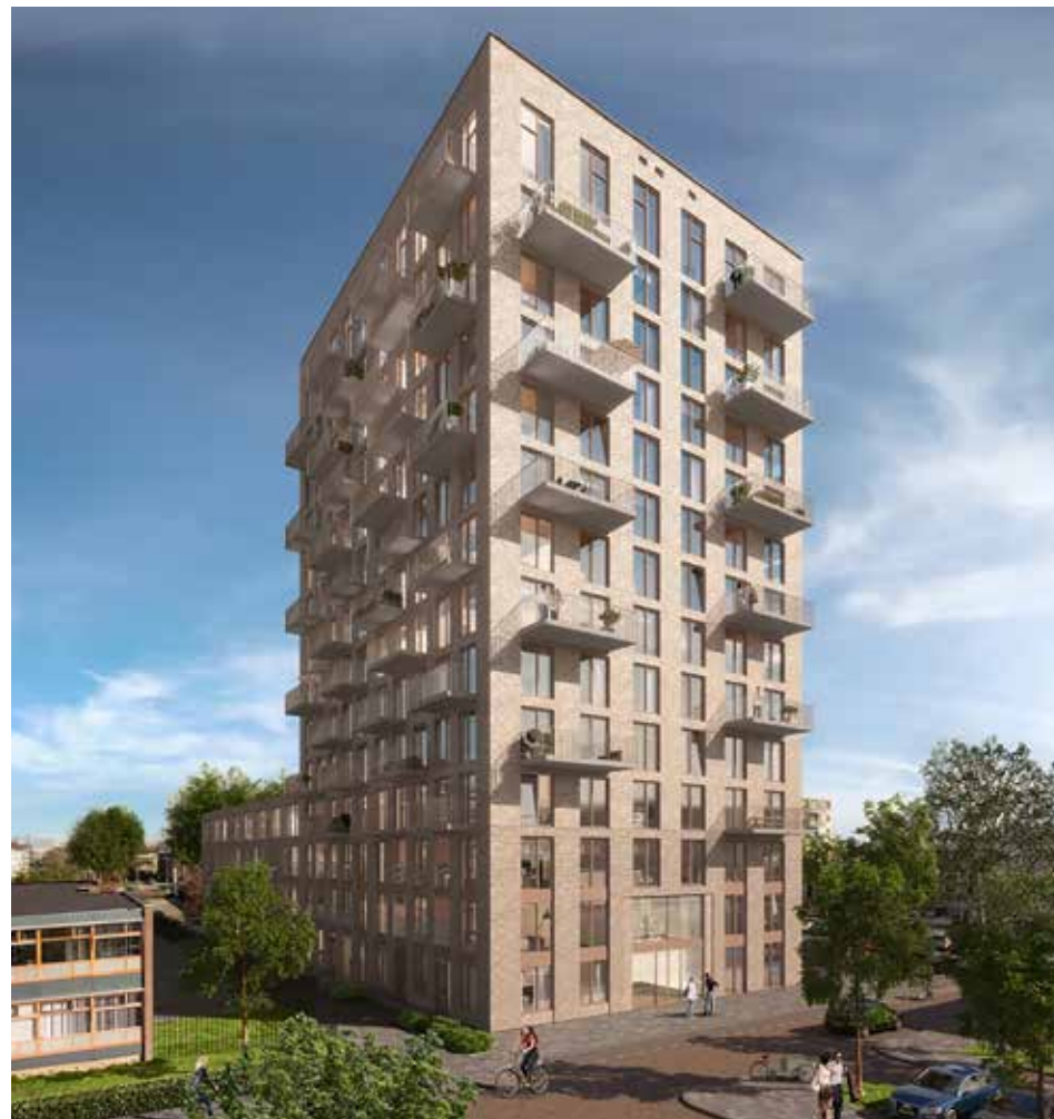
In woongebouw Alex komen 460 kunststof kozijnen, op basis van het K-VISION Trend profiel met schuine hoekverbinding.
